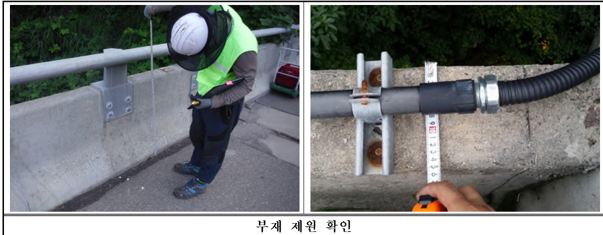
【그림 5.14】 백운4교(춘천) 부재 제원 측정
